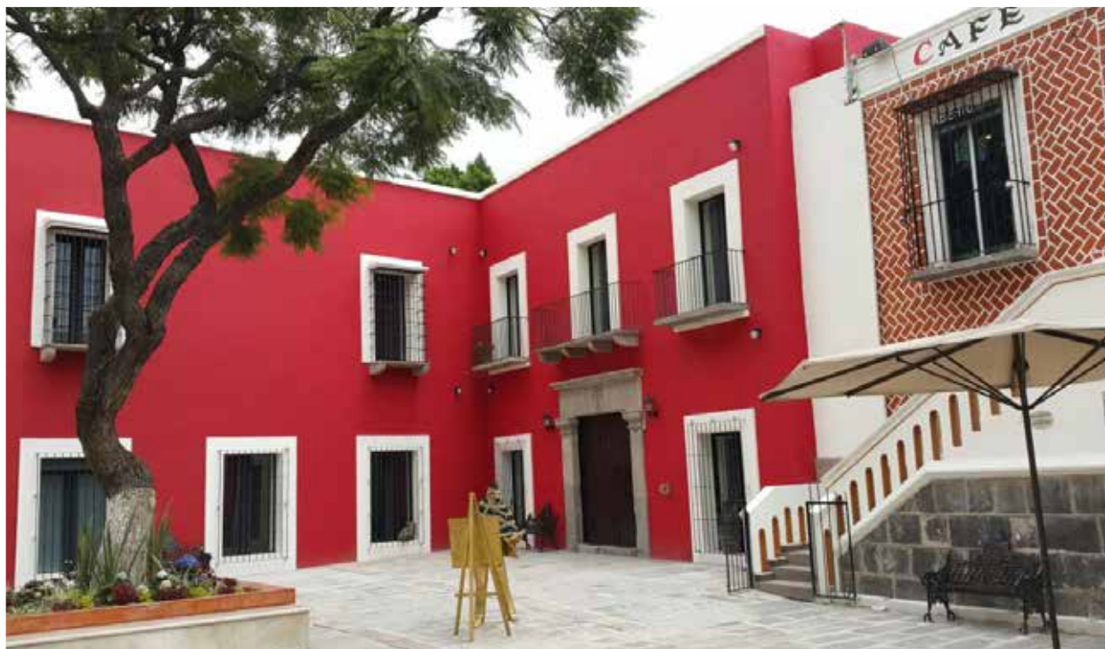
Fachada de la casa del Torno o Colorada recién reconstruida. Foto: Guillermo José Reynoso Sparrow.
