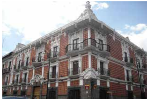
Argamasas en la fachada de la casa de Alfeñique , Puebla de los Ángeles. Foto: José Antonio Terán Bonilla.
