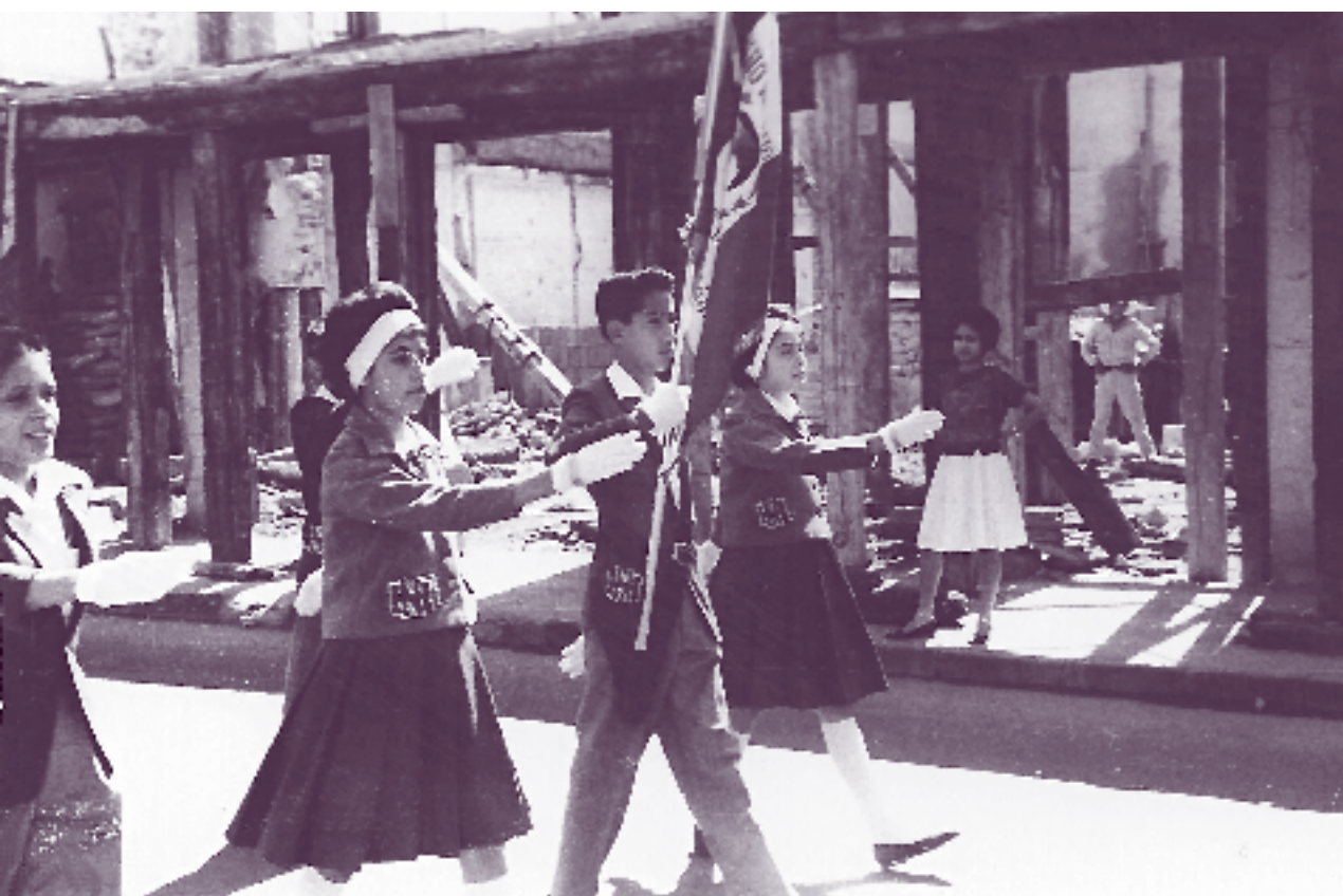
Fotografía de mediados del siglo XX en donde se aprecia, en segundo plano, el final de la demolición del Mayorazgo en San Cristóbal e inicio de obras posteriores.
