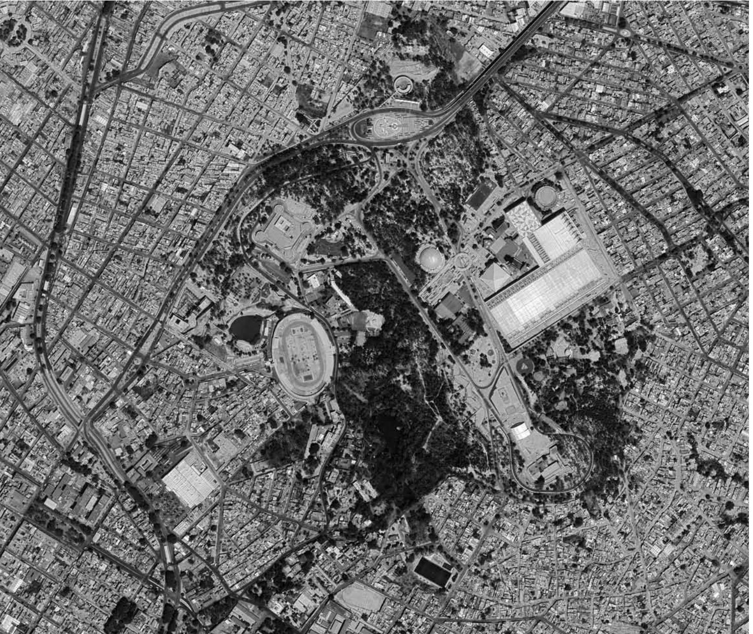
Vista aérea de los Fuertes de Loreto y Guadalupe. Foto cortesía del autor.
