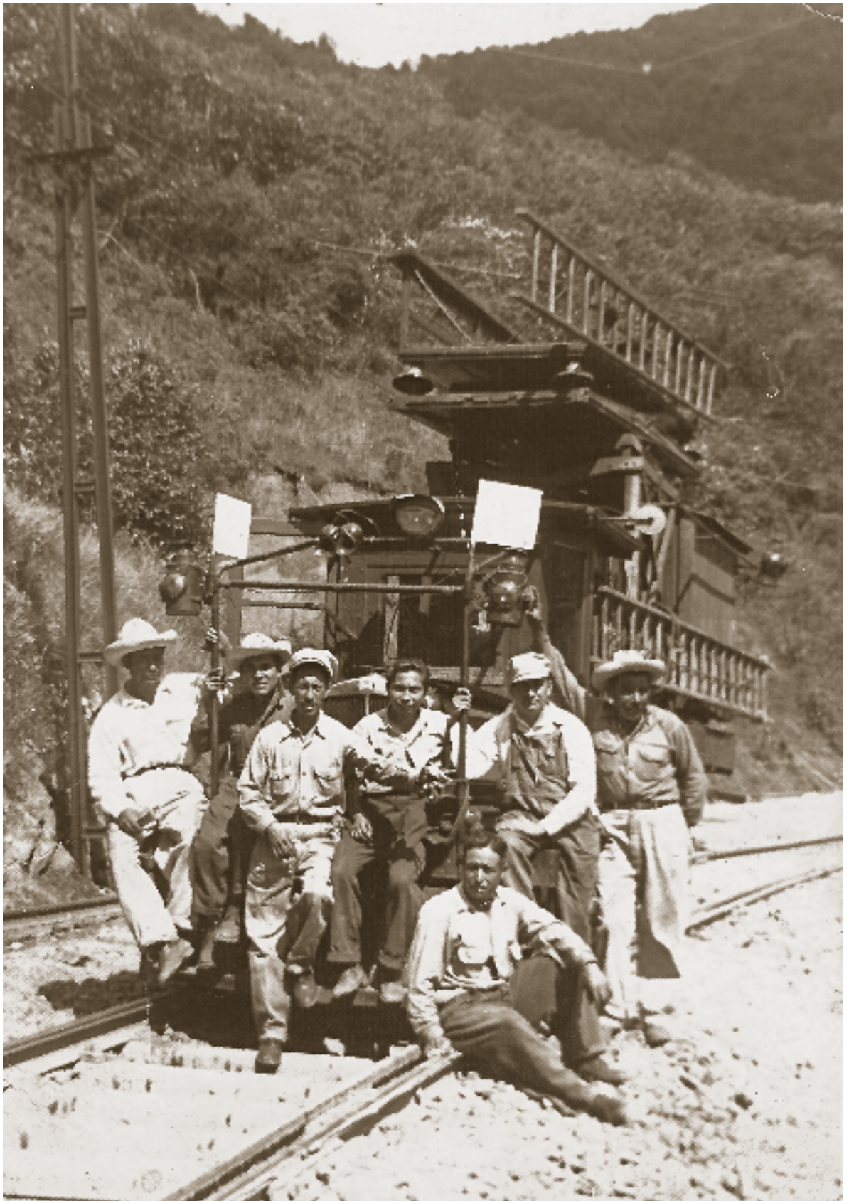
Cuadrilla de trabajadores en "El Motorcito", un vehículo eléctrico usado en tareas de reparación de líneas eléctricas y telegráficas en la línea México-Veracruz. De izq. a der., el segundo es José Lino Vázquez (1925-2014), y en el extremo derecho, de pie, Facundo Lino Conde (1900-1999), jefe de la cuadrilla. Ca. 1943, col. particular fam. Lino Mina.
