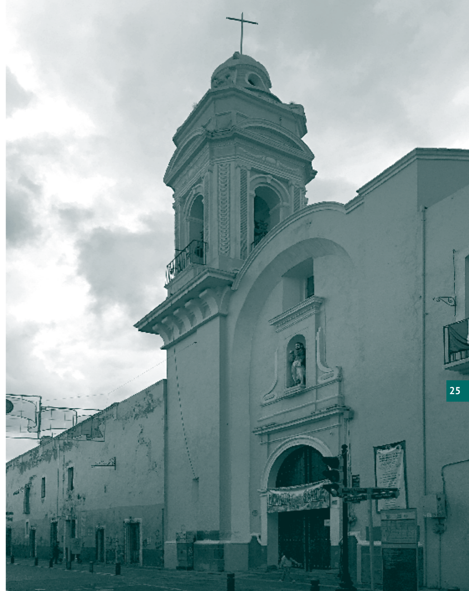
Vista del antiguo Hospital de San Roque. 2020.
