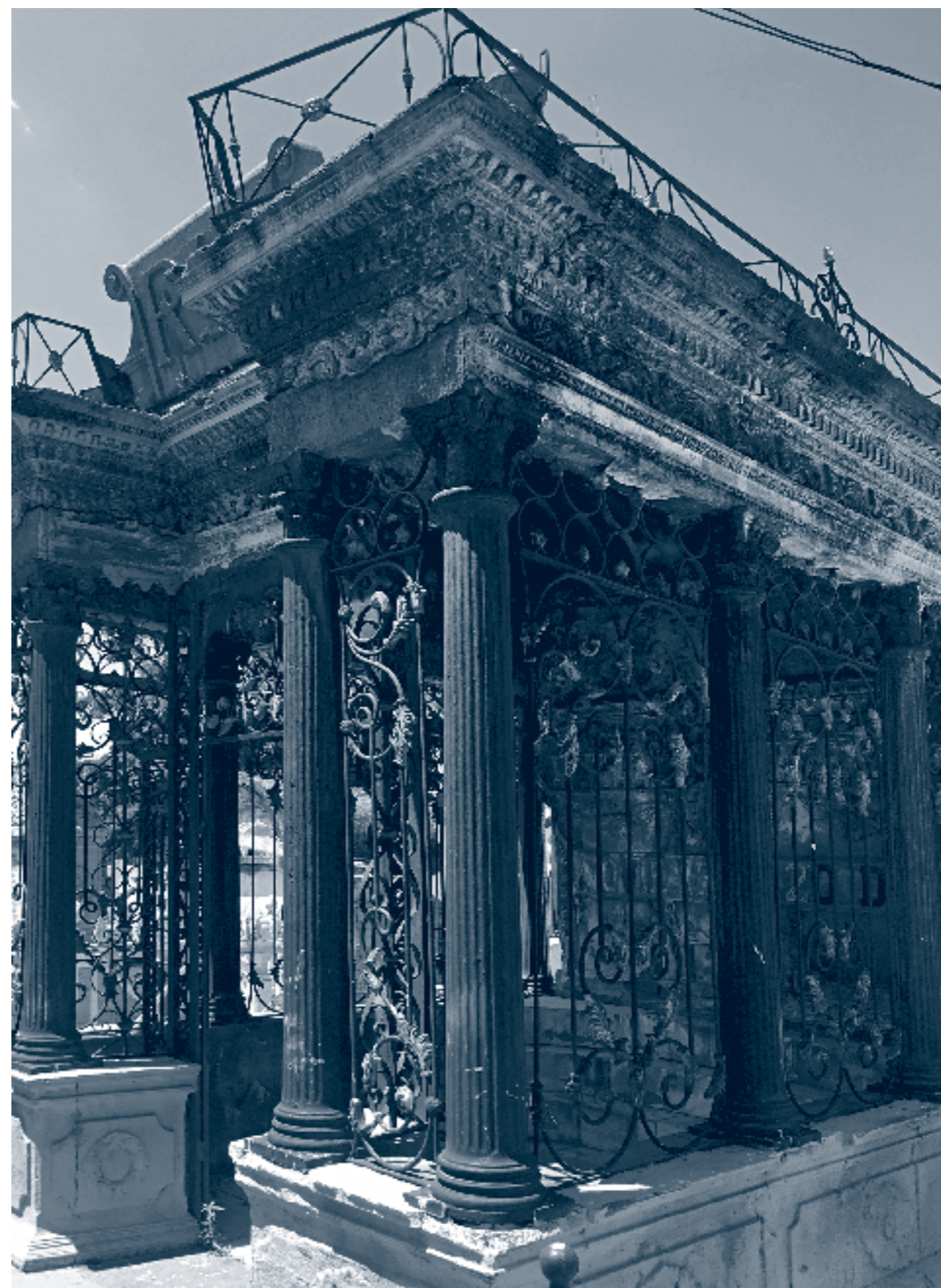
Deterioro de arte funerario. Panteón Municipal. 2020.
