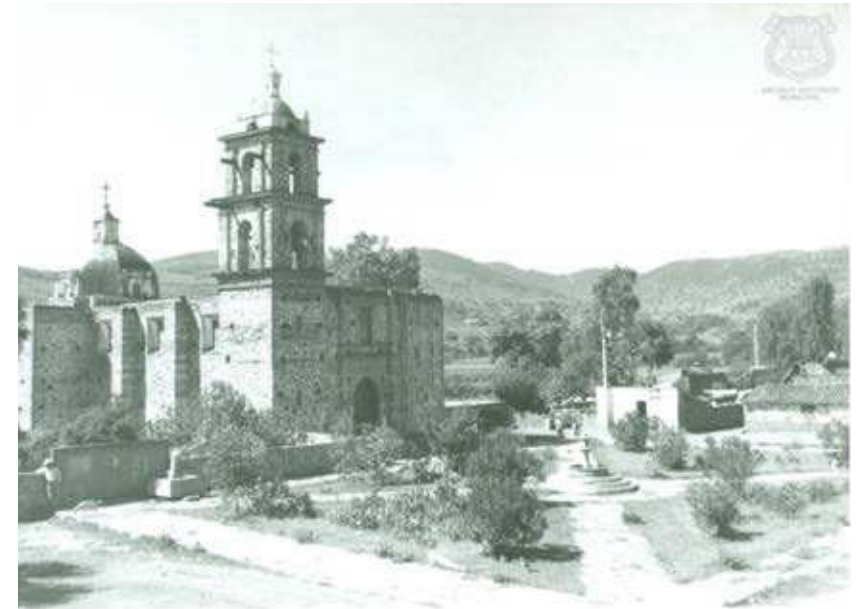
Junta Auxiliar de San Andrés Azumiatla. La imagen muestra el estado que guardaba el atrio antes de ser delimitado por una reja, así como las características del templo antes de la construcción de la segunda torre. AGMP. Material fotográfico, ECM-614, 1975-1978.
