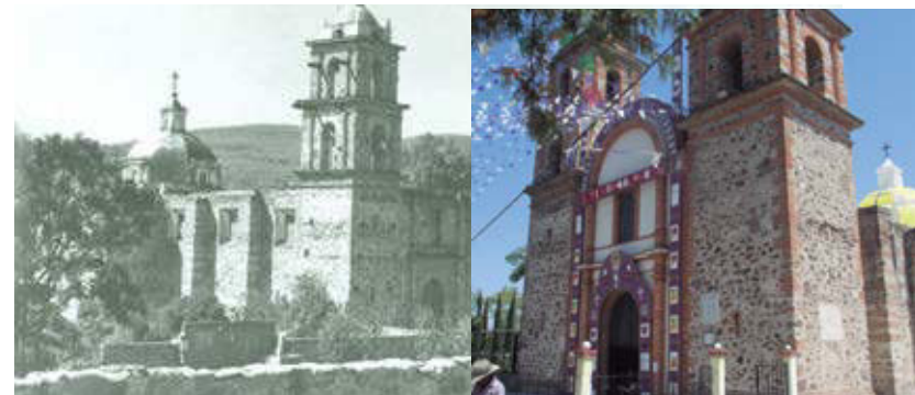
Junta Auxiliar de San Andrés Azumiatla. La imagen revela que no existía una segunda torre, fue agregada más tarde sin diferir en estilo y materiales, lo cual impide reconocerla como de factura reciente. AGMP. Material fotográfico, ECM-615, 1975-1978.
