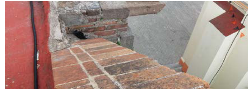
Detalle de la cubierta del templo de San Miguel Canoa
