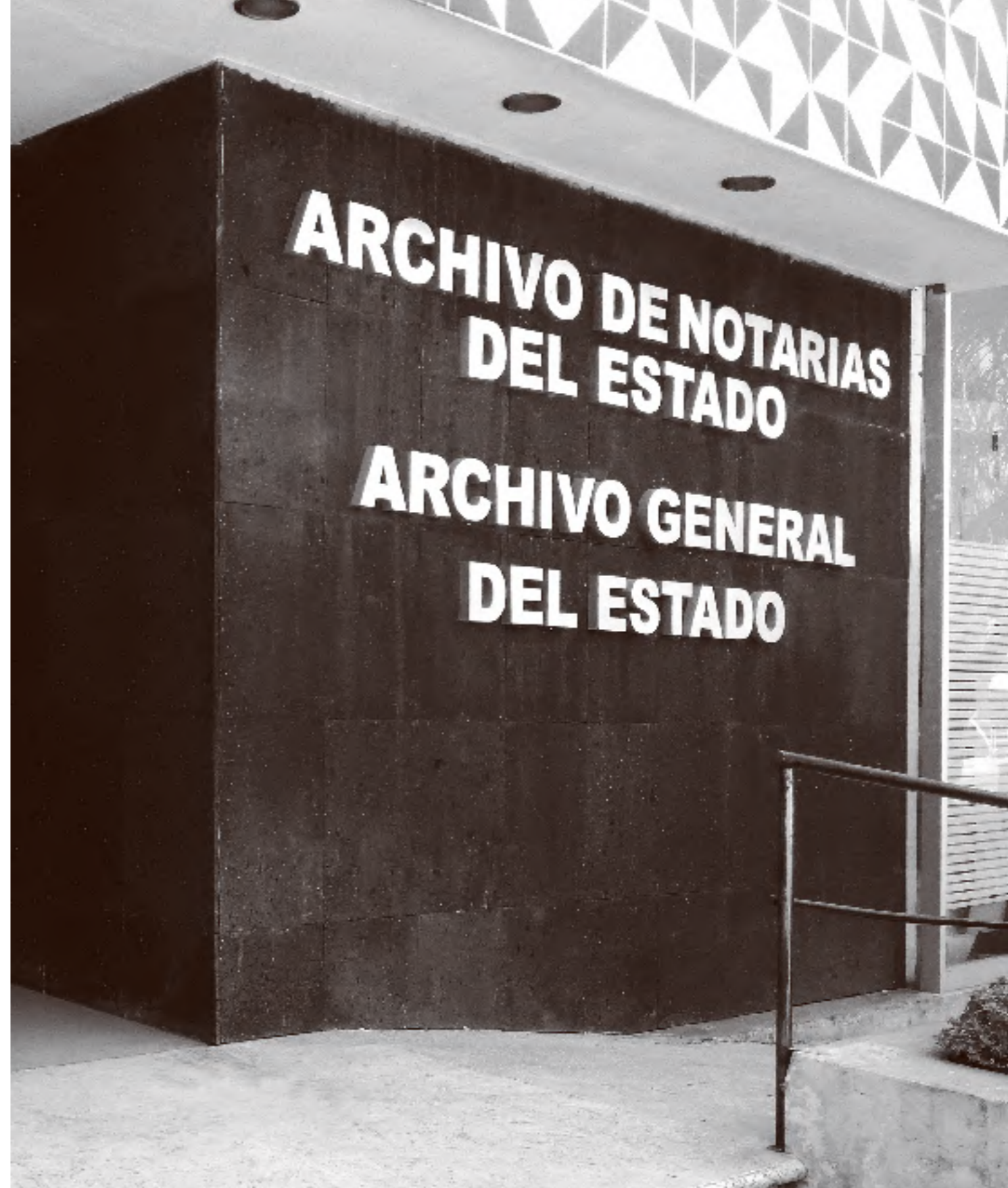
Entrada del edificio donde se ubica el Archivo de Notarías de Puebla.
