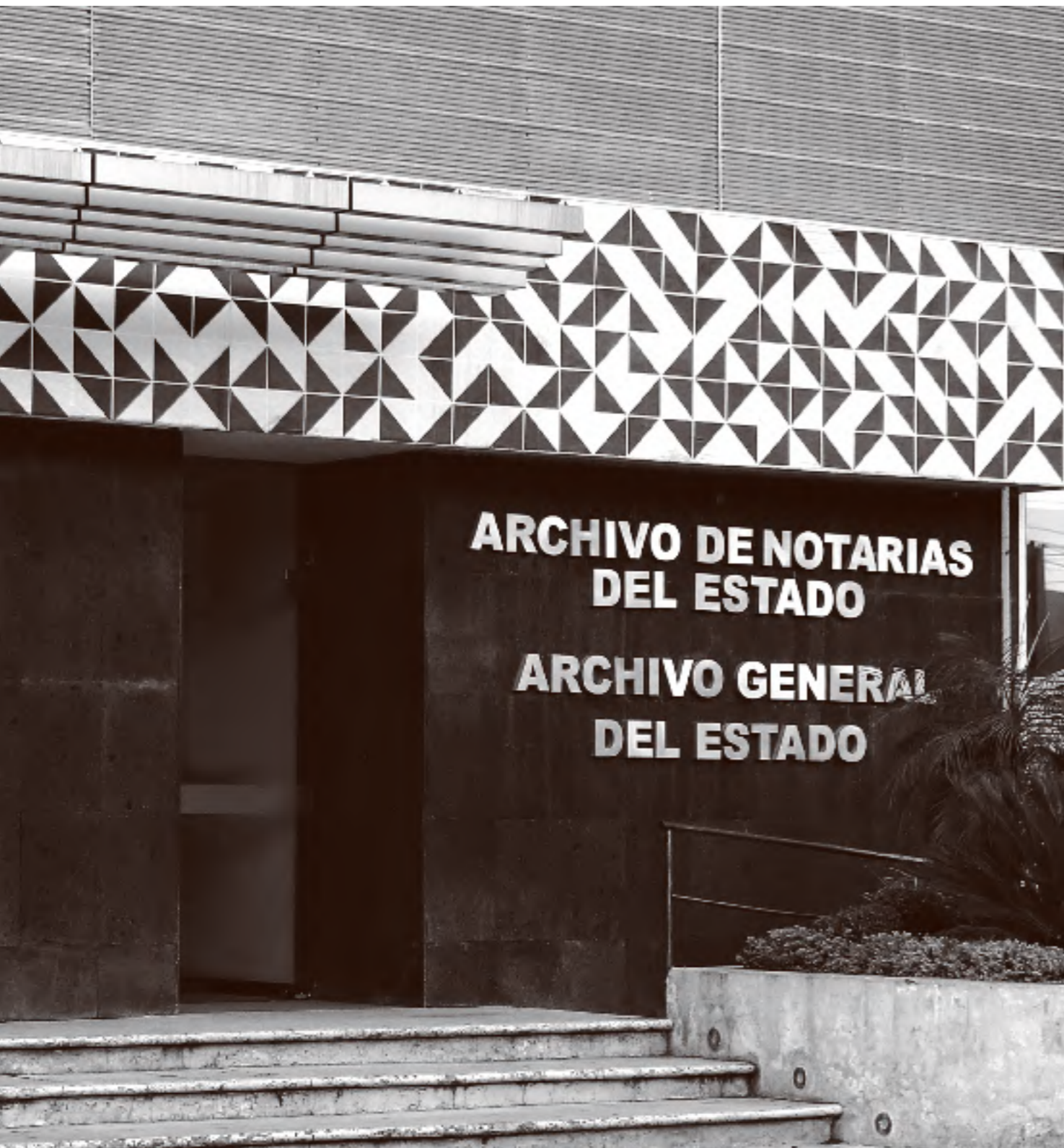
Entrada del edificio donde se ubica el Archivo General del Estado de Puebla.
