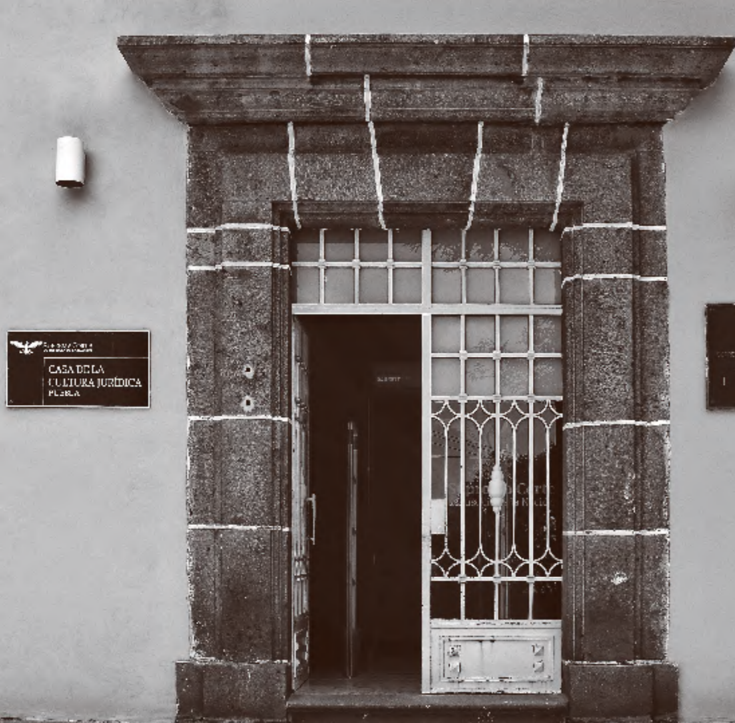
Fachada del edificio que alberga la Biblioteca de la Casa de la Cultura Jurídica Puebla.
