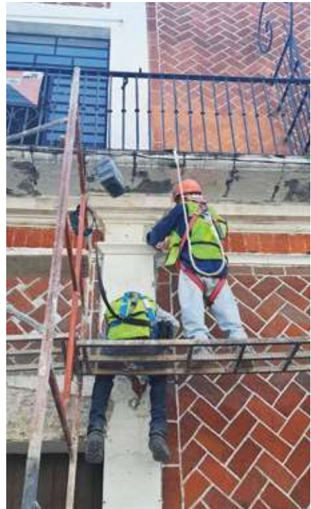
Limpieza de petatillo y aplicación de pintura en jambas. Esquina Calle 16 de septiembre y 15 oriente, El Carmen.
