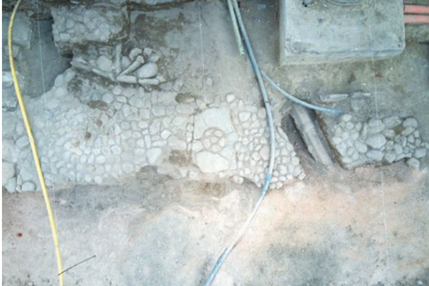
Imagen 5. Vista aérea del empedrado o Calzada, se puede observar en la parte central los diseños que se colocaban, en la partes izquierda superior se puede observar la guarnición de la banqueta que se realizaba en ese period. (Fuente: PSACCHCP)
