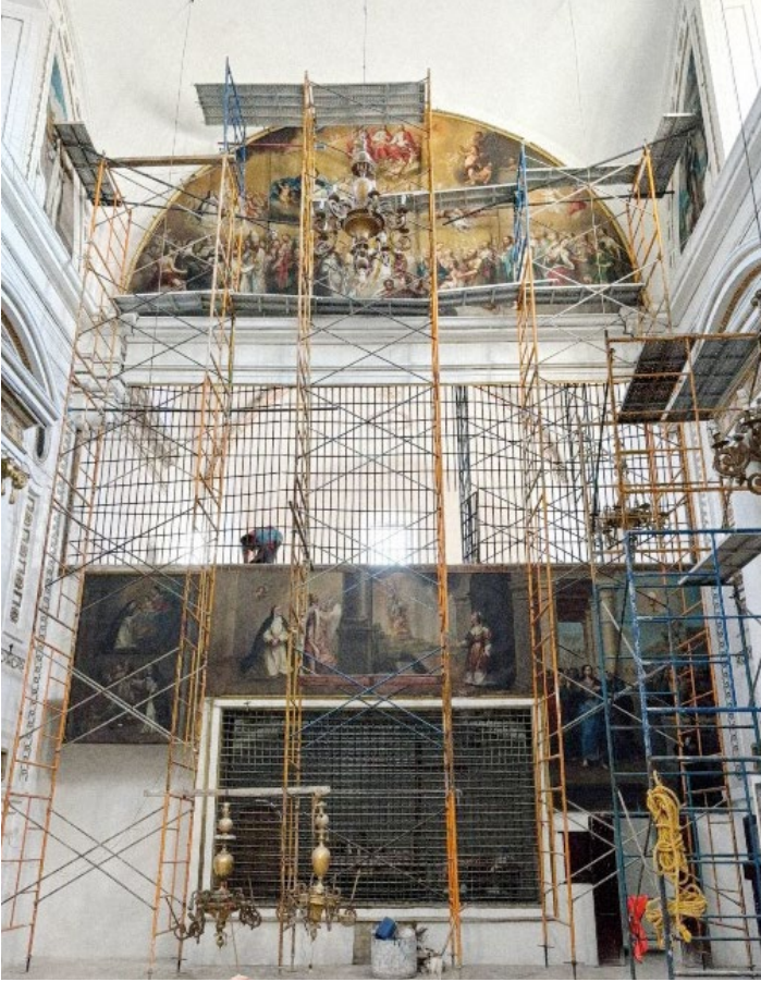
Imagen 12. Proceso de limpieza de pintura de caballete de medio punto que implica el retiro de materiales ajenos a la obra sin afectar la capa pictórica original, ubicada sobre el cancel de coro. (GPX S.A de C.V 2025)
