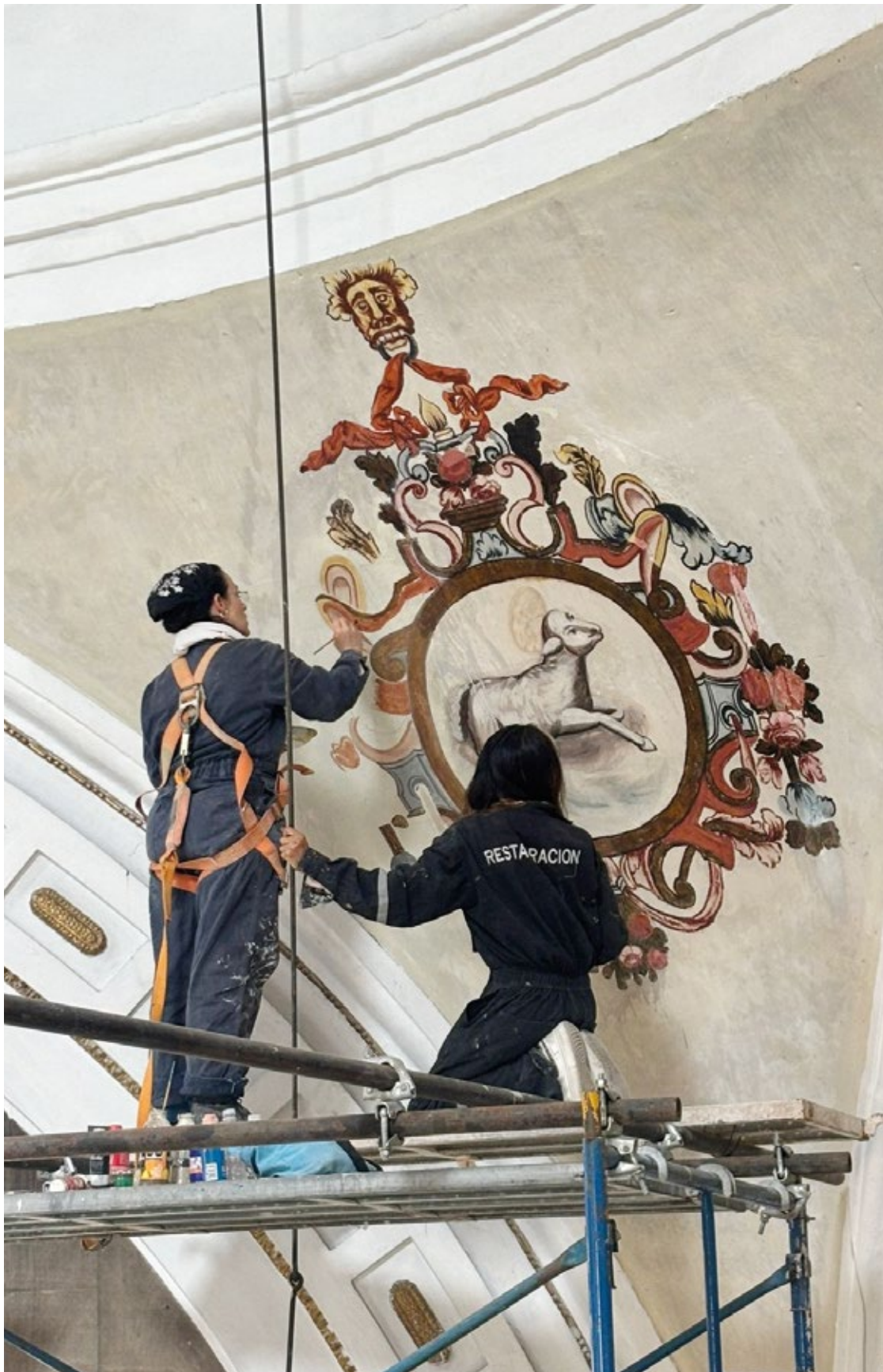
Imagen 10. Retiro de lienzos en área de pechinas de cúpula, dejando al descubierto pintura mural correspondiente al siglo XIX. (GPX S.A de C.V 2025)
