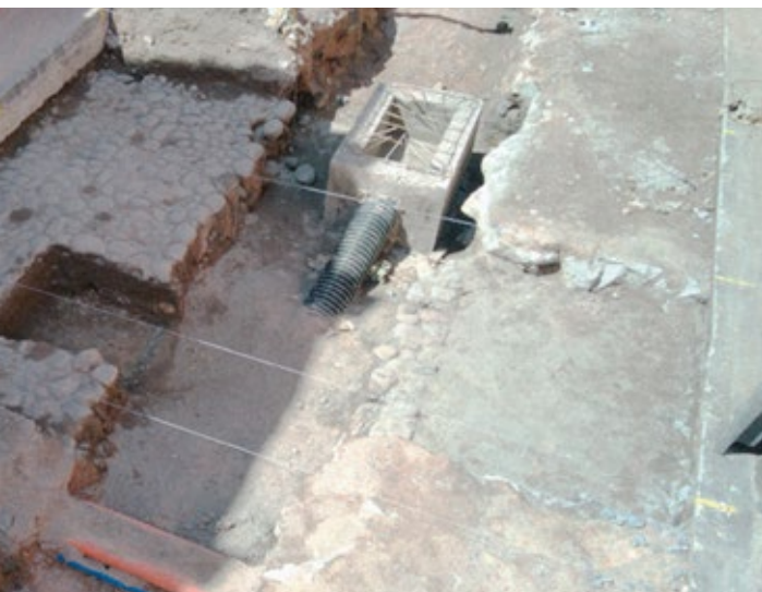
Imagen 6. Vista aérea del empedrado localizado en la calle 16 de septiembre entre las calles 15 y 13 poniente, frente a al templo de la Mansión Clerical San Juan Nepomuceno, se puede observar que el empedrado abarca el ancho de la calle que fue dividida para introducir el drenaje y alcantarillas. (Fuente: PSACCHCP)
