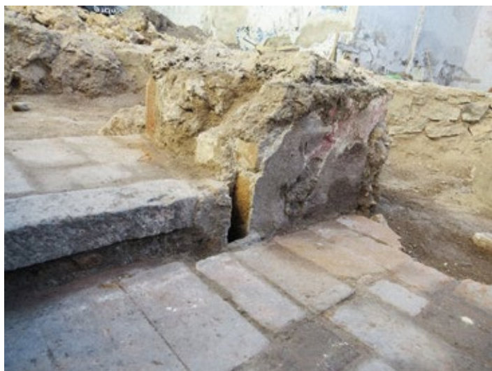
Foto 5. Detalle de una esquina de muro revocado conservando de junta con piso de tabiques rojos y escalón.
