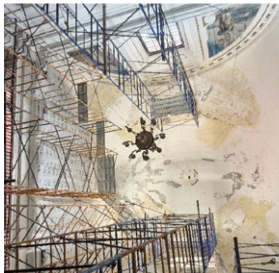
Imagen 9. Vista del intradós de la bóveda vaída del tercer tramo de la nave principal, donde se realizaron trabajos de consolidación por el intradós, restitución de aplanados abofados y aplicación de pintura a la cal. (GPX S.A de C.V 2025)
