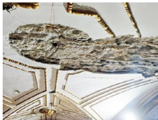
Imagen 6. Liberación de aplanados en intradós de bóvedas durante trabajos de restauración. (María Catalina Montiel Romero, 2024)
